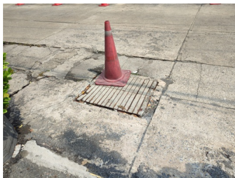
ภาพที่ 4-6 ฝาที่ระบายน้ำริมถนนอินทามระ 49 มีความชำรุดเสียหาย ทางโครงการได้แจ้งไปยังสำนักงานเขตไว้แล้วให้มาตรวจสอบซ่อมแซม
